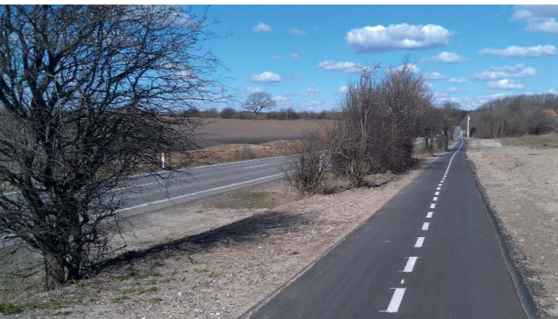
Fotoet viser en nyanlagt sti nord for Aabenraa ved Haderslevvej. Denne anlægstype modsvarer den type der ligger til grund for anlægsoverslagspriserne på Ærø. Enhedspriserne er beregnet på grundlag af regnskabet for blandt andet denne sti. Stien er anlagt i 2015.
